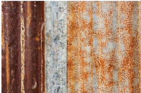
Gambar 2.1 Korosi pada baja ringan ( Hybrid Coating Tech )
