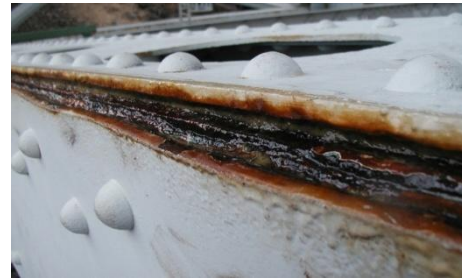
Gambar 2.3 Korosi pada celah ( Steel Fab Services )
