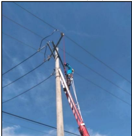
Gambar 6 Pembebasan Tegangan Sebelum Pekerjaan Sumber : PLN ULP Alas (2025)
