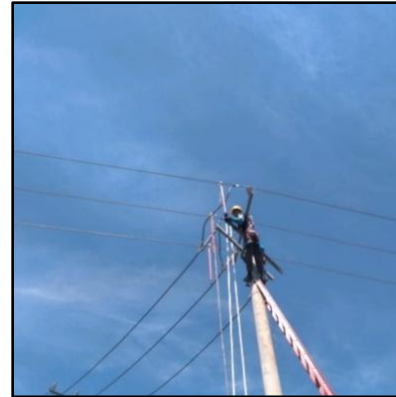
Gambar 7 Pemasangan Grouding Set Sumber : PLN ULP Alas (2025)
