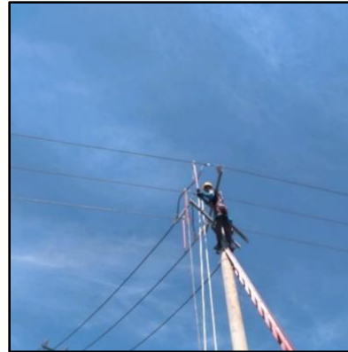
Gambar 7 Pemasangan Grouding Set Sumber : PLN ULP Alas (2025)
