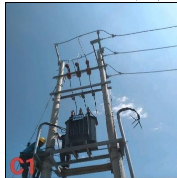
Gambar 8 Pelaksanaan Pekerjaan Perubahan Tap Trafo Gardu AL016 Sumber : PLN ULP Alas (2025)
