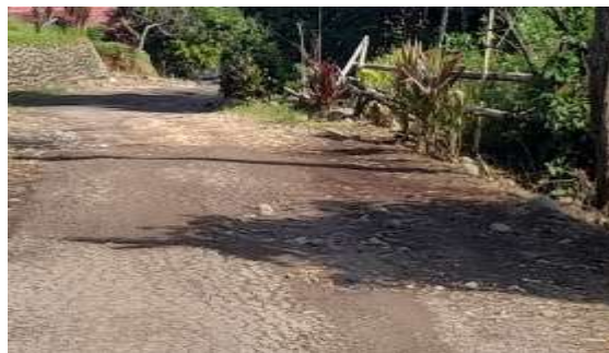
Gambar 4. Pengelupasan Lapis Permukaan
