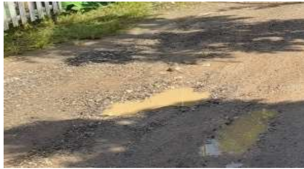
Gambar 5. Kerusakan Lubang
