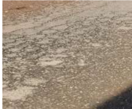
Gambar 2. Retak Kulit Buaya
