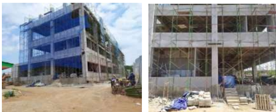
Gambar 2. Proyek pembangunan gedung Rumah Sakit Mata Makassar
