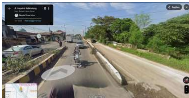
Gambar 3. Kondisi Eksisting Ruas Jalan Inspeksi Kalimalang (Segmen 2)
