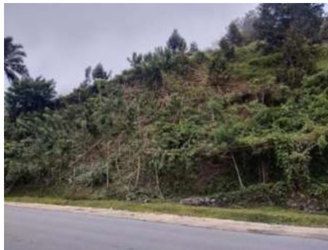
Gambar 1. Kondisi Lereng Di Kebun Kopi Km 26+57
