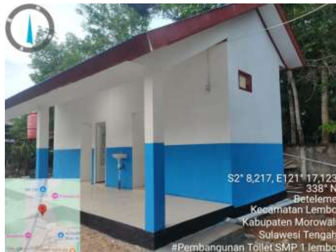
Gambar 2. Pekerjaan Revitalisasi SMP
